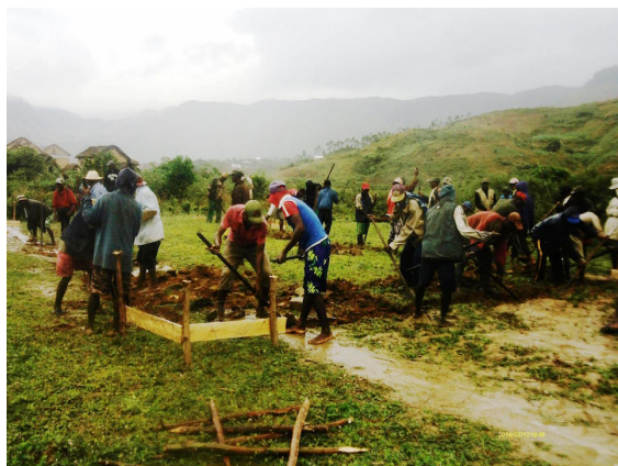
Figura 3: scavo delle fondazioni
