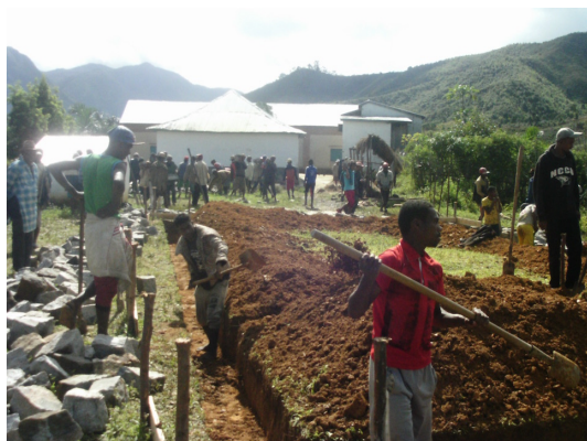
Figura 3: scavo delle fondazioni
