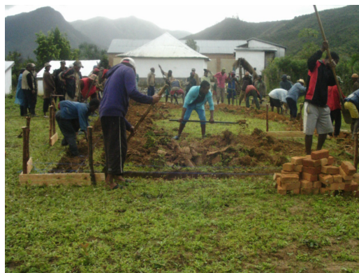
Figura 4 : scavo delle fondazioni
