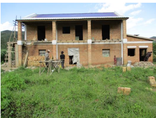
Figura 5: Il nuovo Centro di formazione professionale di Tsiryparma in fase di ultimazione e di prossima apertura
