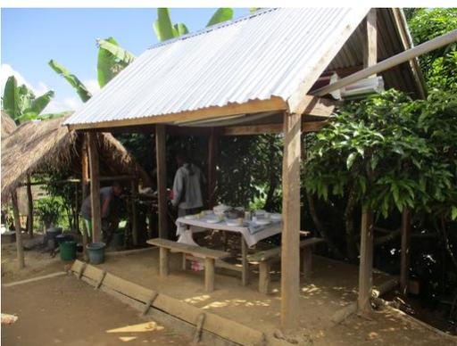
Abbiamo iniziato i lavori per sostituire il capanno vecchio con il tetto in paglia e la paleria marcia con uno nuovo. I pali sono ricoperti alla base di cemento armato per proteggerli dall'umidità ed il tetto non è più in paglia ma in lamiera. Tale capanno ospita sotto le pietre per sostenere le pentole, accendere il fuoco e cucinare. A fianco c'è il capanno con la tavola adibito a sala da pranzo.
