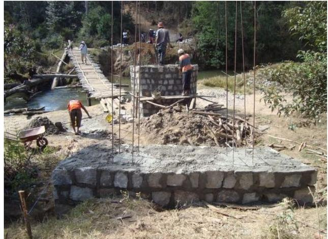
**Figura 17: Il camion che ha trasportato ferro e cemento da Ambositra. Differenti fasi di lavoro per la costruzione del ponte. Per ora sol due piloni su quattro sono stati costruiti. Uno dei quattro sarà più complicato da costruire in quanto va innalzato nel mezzo del corso d'acqua. Quello attuale, è il vecchio ponte che verrà soppresso una volta che il nuovo verrà costruito.**
