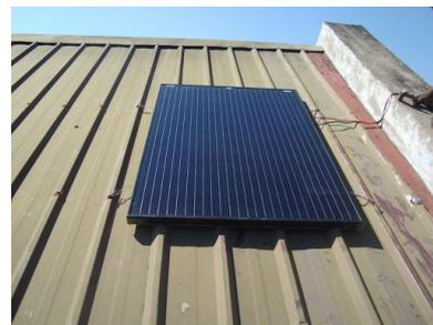
**Figura 8: Il pannello solare da 150 watt installato sopra il tetto del centro agricolo.**
